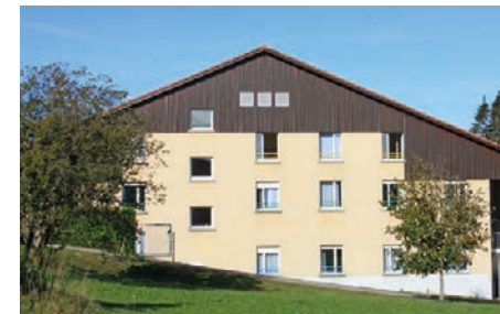
Résidence sur 3 niveaux à 1 000 m d'altitude
