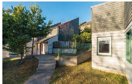
Logements en duplex
